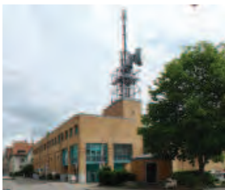
Gebäude mit Telekommunikationsturm. Eine andere Form von räumlicher Prägung.
