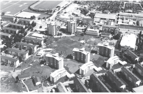
Siedlung Heiligfeld, Zürich, 1951-55 von Albert Heinrich Steiner: Städtebauliche "Urbarmachung" einer Randzone mit differenzierter Bebauung.
