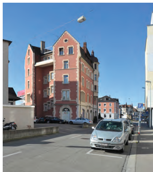
Dominantes Gebäude an der Poststrasse, das am Platz zur Unteren Bahnhofstrasse eine Funktion als Landmark hat.
