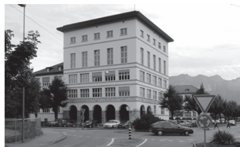
Städtebauliches Potential des Höheren Hauses: Beispiel Pestalozzischulhaus Thun. Eine kleine Abweichung von der übrigen Gebäudehöhe genügt bereits, um gezielt eine gewisse Dominanz zu erreichen.
