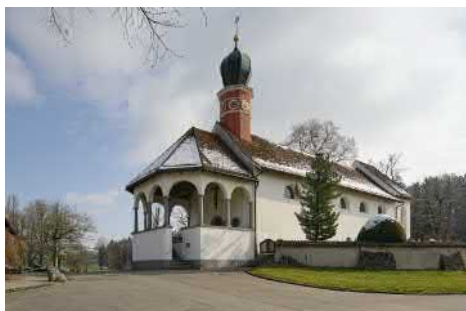
Ansicht von Südwesten an die Vorhalle.
