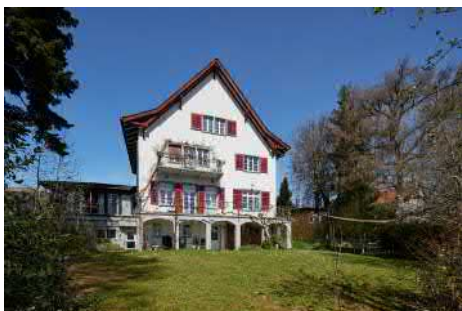
Gartenpartie, Ansicht von SW.
