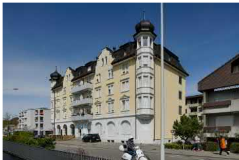
Ost- und Südfassade.
