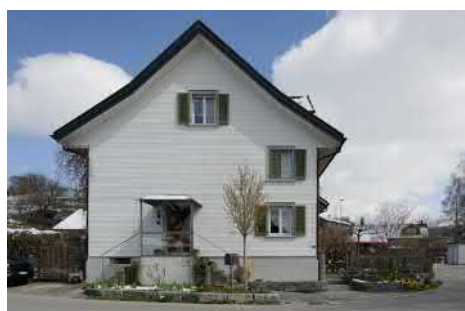
Südwestfassade mit Eingang.
