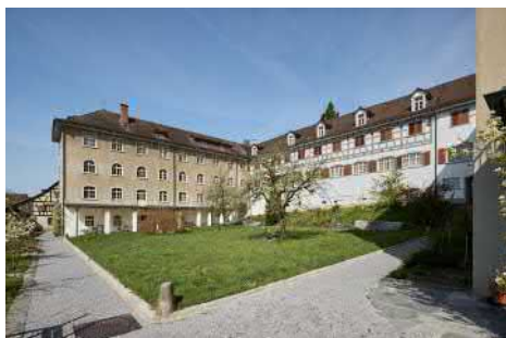
Innenhof Erweiterungsbauten, Ansicht von SO.
