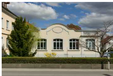
Wohnhaus und Stickereifabriktrakt.
