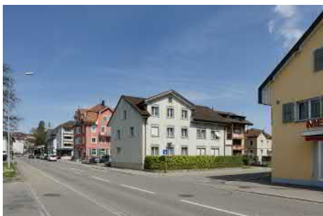
Toggenburgerstrasse, Höhe Nr. 55, Blick nach Norden.
