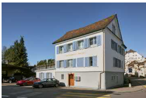
Nord- und Westfassade.
