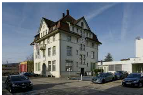
Geschäftshaus von Südosten.
