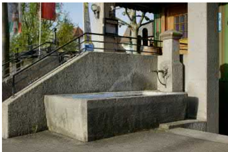
Ansicht von Osten.
