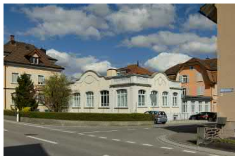
Fabriktrakt mit Vorgarten.
