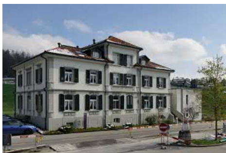
Nord- und Westfassade.
