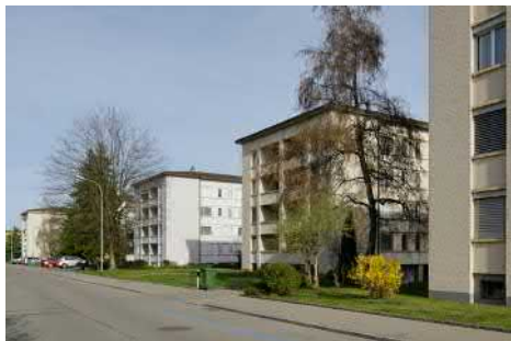
Gallusstrasse, Blick nach Westen.
