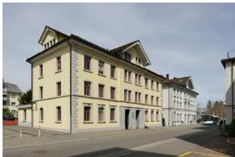
Südwest- und Südostfassade.
