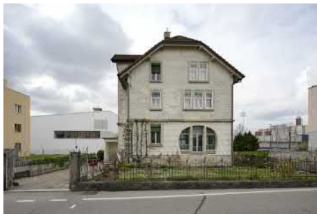
Ostfassade an der Wilenstrasse.
