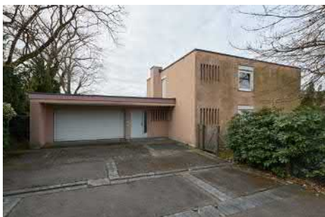
Ansicht mit Eingang und Garage.
