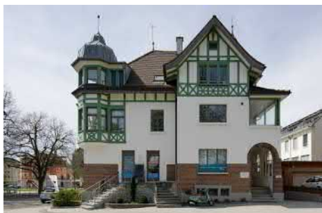
Ostfassade mit Eingang.
