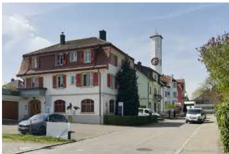
Florastrasse, Blick nach Westen.
