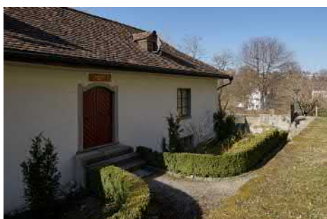
Eingang an der Südostfassade.
