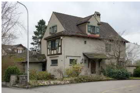
Ost- und Nordfassade mit Eingang.
