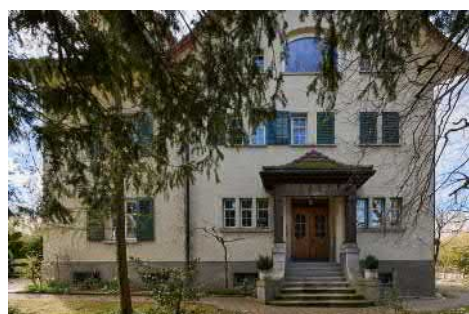
Nordfassade mit Eingangsportal.
