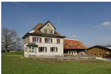
Blick von Süden an das Wohnhaus.
