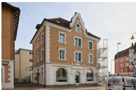
Hauptfront gegen die Kanal-Strasse.
