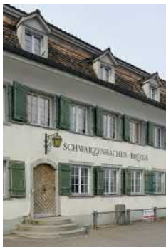
Portal in der Südfassade.
