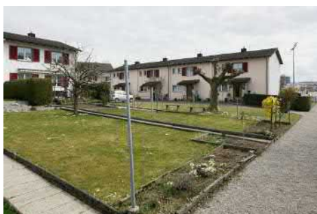
Hausgärten der Haus-Nrn. 28-30 & 32-38, Ansicht von NW.
