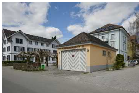
Ansicht von Süden mit Parkanlage.
