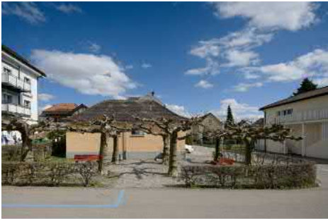
Gesamtansicht, Ansicht von W.
