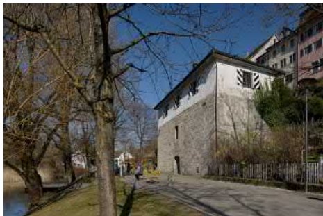
Nordwest- und Südwestfassade.
