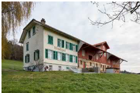
Ansicht von Südenwesten.
