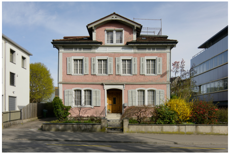
Westfassade mit Eingang.
