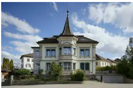
Fassade gegen die Hörnlistrasse.
