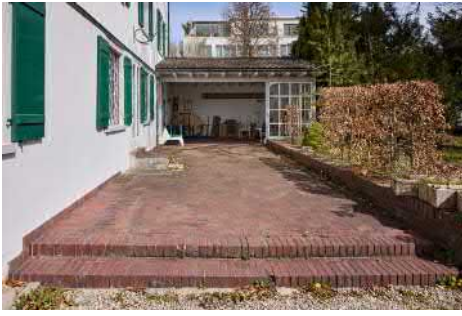
Terrasse der Gartenhalle, Ansicht von S.
