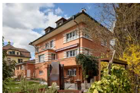
Südfassade zum Garten.
