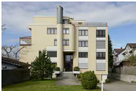
Ostfassade mit Eingang.
