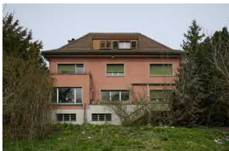
Gartenfassade gegen Süden.
