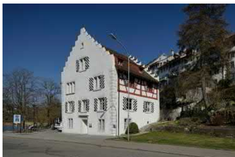
West- und Südfassade.
