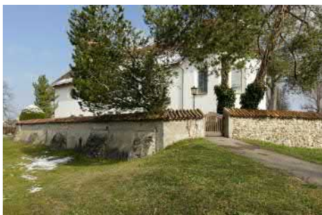
Kirchhofmauer, Ansicht von SO (Friedhofweg).
