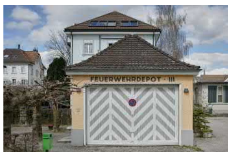
Haupttor mit Diagonalschalung.
