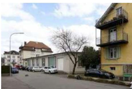
Signalstrass. Blick nach Südosten.
