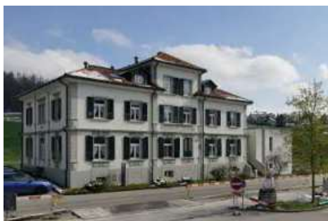
Nord- und Westfassade.
