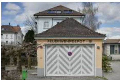
Haupttor mit Diagonalschalung.
