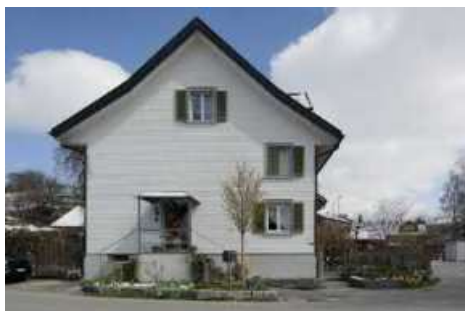
Südwestfassade mit Eingang.
