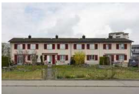
Feldstrasse 14-22. Ansicht von Osten.
