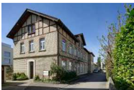
Ost- und Nordfassade.
