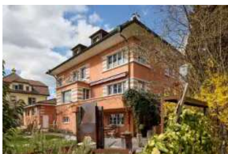
Südfassade zum Garten.
