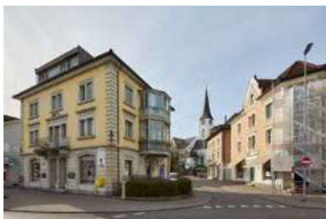
Jupiterkreisel, Blick in die Kanalstrasse.
