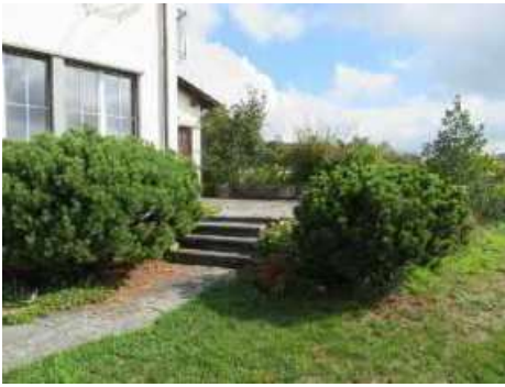
Terrasse, Blick von SW (16.09.2018).
