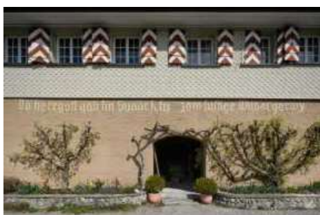
Portal in der Südwestfassade.
