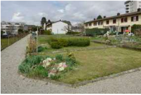
Westlicher Erschliessungsweg, rechts Haus-Nrn. 14-22, Ansicht von S.
