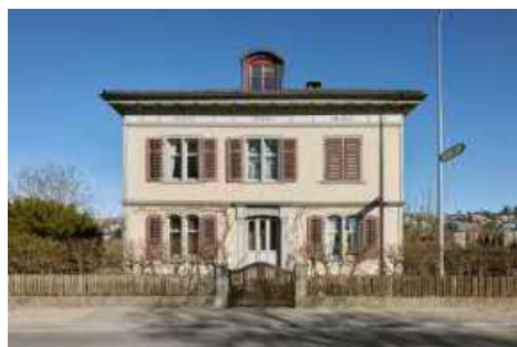
Südostfassade mit Haupteingang.
