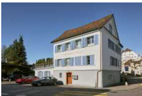
Nord- und Westfassade.
