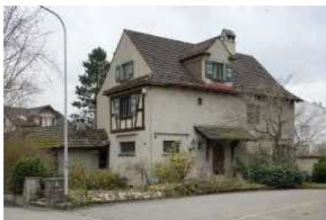
Ost- und Nordfassade mit Eingang.
