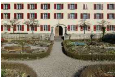
Längsachse mit Sandsteinsäulen, Ansicht von SO.
