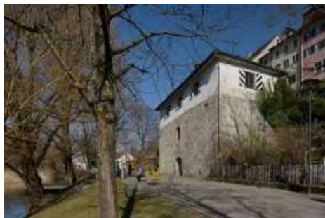
Nordwest- und Südwestfassade.
