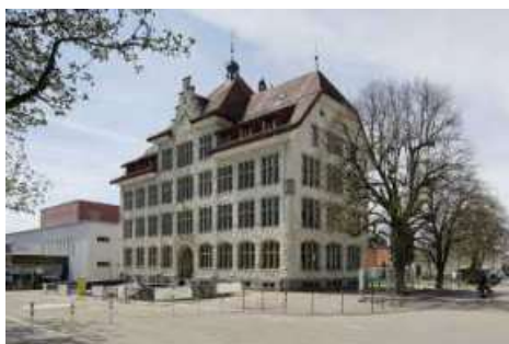
Nord- und Ostfassade.
