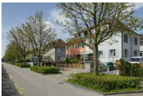
Weststrasse, Blick an die Häuser der südlichsten Reihe.
