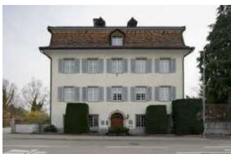
Ostfassade mit Portal.
