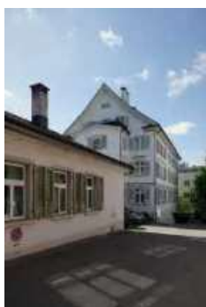
Nordfassade des Anbaus.
