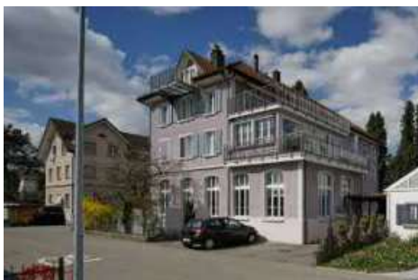
Süd- und Ostfassade.
