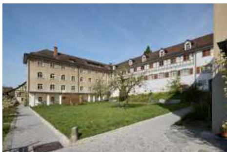
Innenhof Erweiterungsbauten, Ansicht von SO.
