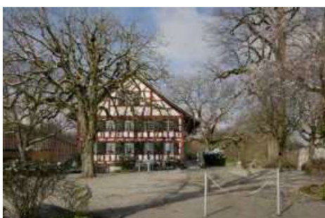
Pfrundhaus. Ansicht von Osten.
