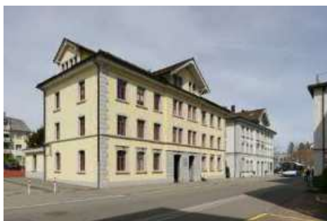
Südwest- und Südostfassade.
