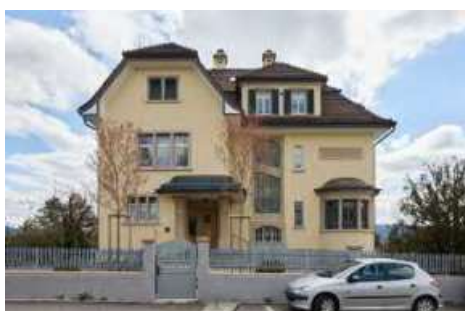
Nordfassade mit Haupteingang.
