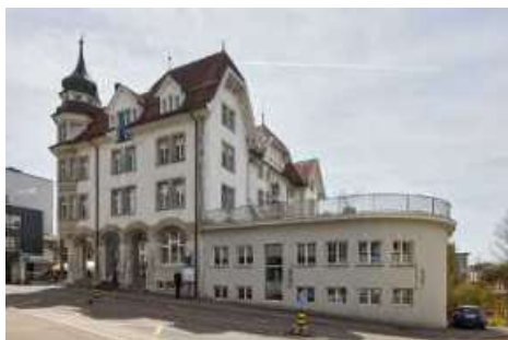
Ansicht von Nordosten.
