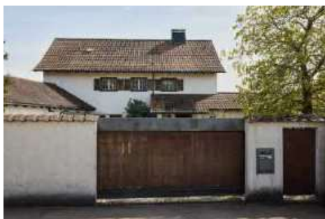
Ansicht von Norden mit Zufahrt.
