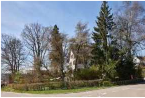
Grundstückszufahrt mit Einfriedung von 1969. Ansicht von O.
