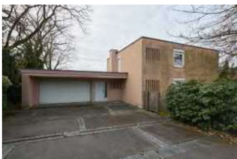
Ansicht mit Eingang und Garage.
