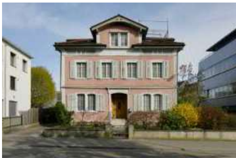
Westfassade mit Eingang.
