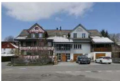
Südostfassade gegen die Strasse.
