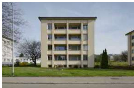
Ansicht Gallusstrasse 45 von Norden.
