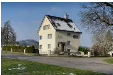
Ansicht von Nordosten.
