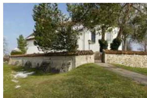
Kirchhofmauer, Ansicht von SO (Friedhofweg).
