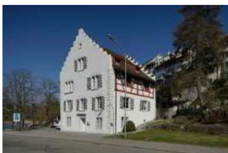
West- und Südfassade.
