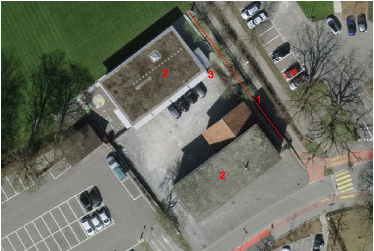
Abbildung 7: Übersicht zum Standort des Kindergartens Paradiesli an der Haldenstrasse 12, Wil. (Quelle: Orthofoto 2019; geoportal.ch)
