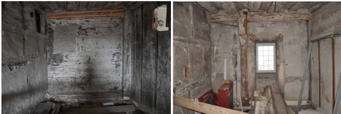
Abb. 63: Einblick in den Raum R323. (Fotos: Thomas K. Keller Architekten GmbH)
