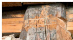
Salon: Grundstruktur des Hofes ist eine Ständer-Holz-Konstruktion um 1400. Holzständer mit Nuten sind auf einem Schwellenholz verzapft. Dazwischen werden dicke Holzbohlen mit Kaminen eingelagt.
