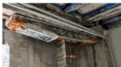
Hauszimmer: Die Stütze und die Balken haben verschiedene Malereien. Das Blau war zu dieser Zeit (16. Jh.) sehr teuer und repräsentativ. Teilweise wurden Holzer aus- und an anderer Stelle wieder eingebaut oder auch erst später eingesetzt.
