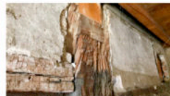
Stadelhalle: Abgesiegter Usterzug und Erhöhung der Decke. Solche Überformungen kommen im Hof immer wieder vor.
