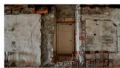
Stadelhalle: alte Öffnungen - welche hier vor 1693 bestanden - weisen auf die vielen Veränderungen im Hof hin.
