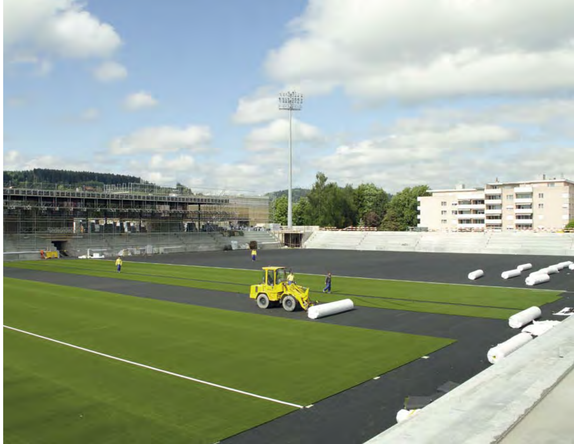
Der Kunstrasen wird wie ein grosser Teppich ausgerollt, millimetergenau ausgerichtet und fixiert.
