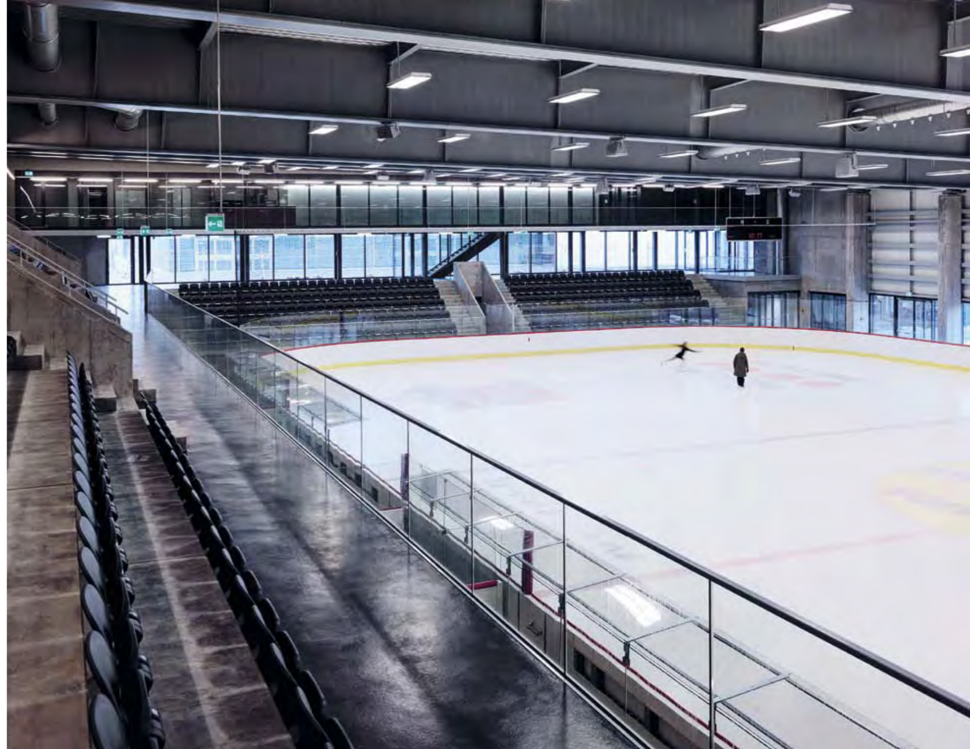
Mächtige, bis zu 45 Meter lange Stahlträger spannen sich über die Eishalle und verleihen dem Raum ein besonderes Gepräge.
