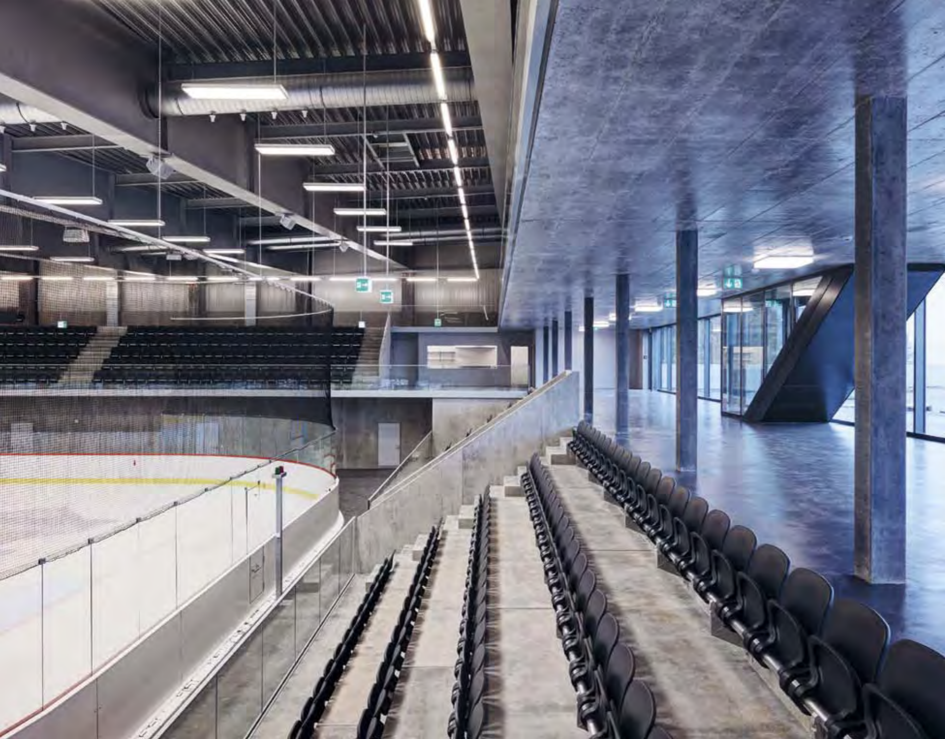
Energieeffiziente Eiserzeugung und konsequente Abwärmenutzung bilden wichtige Eckpfeiler im Energiekonzept des Sportparks.
